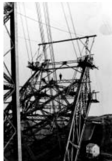
Le montage de l'arche du viaduc de Garabit.
