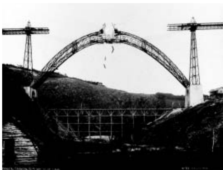
Achèvement de l'arche du viaduc de Garabit.
