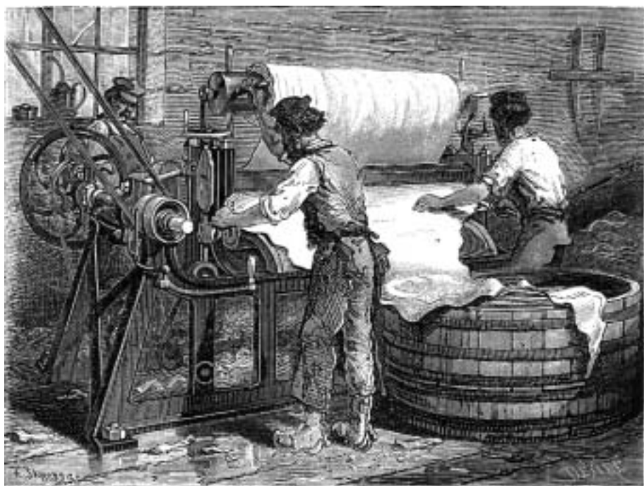
Machine à refendre les peaux fraîches, v. 1860, in : Louis Figuier, Les Merveilles de l'Industrie, industrie des cuirs et des peaux .
