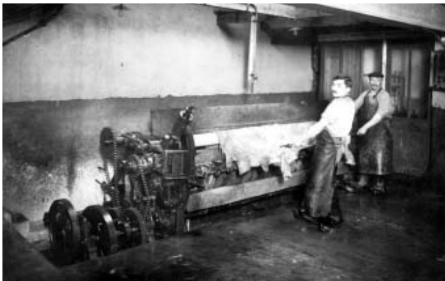
Écharnage à la machine. Photo v. 1900. Coll. L. Bastard.
